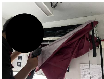
ภาพที่ 2.1-13 การล้างทำความสะอาดเครื่องปรับอากาศ
