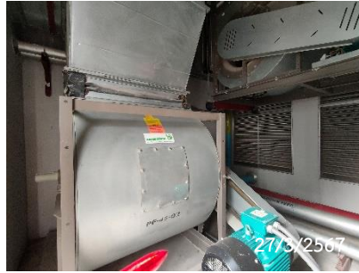
ภาพที่ 2.1-11 ระบบระบายอากาศของโครงการ
